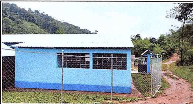
Foto1: LAMINAS SUSTITUIDAS Y FINALIZDA.
