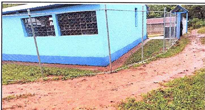
Foto 3: CERCO PERIMERIMETRAL SUSTITUIDO Y FINALIZADO
