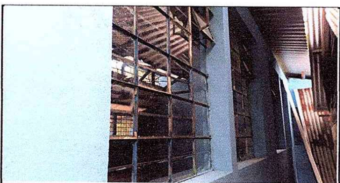
Foto 5: VIDRIOS SUSTITUIDOS Y FINALIZADO
