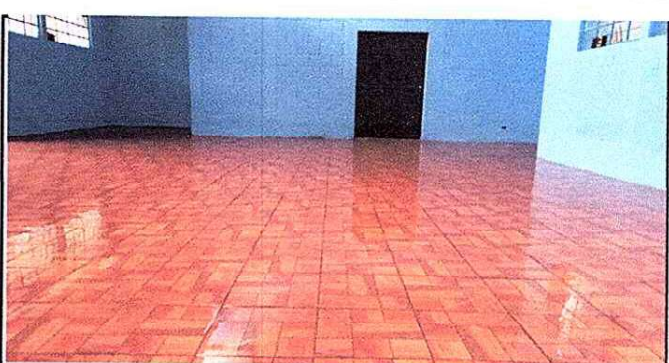
Foto 6: PISO SUSTITUIDO Y FINALIZADO
